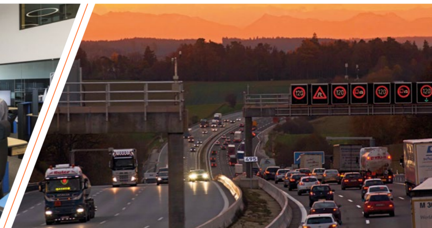
A9, Seitenstreifenfreigabe: Die Steuerung entsprechend Verkehrsaufkommen und Witterungsbedingungen erfolgt mittels Telematik.
